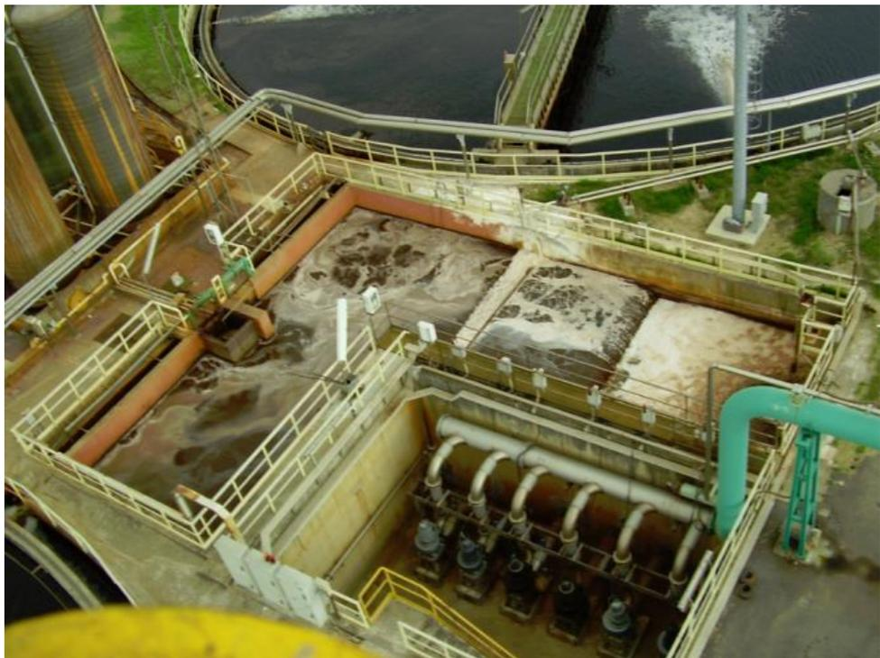
Trattamento FENTON per l'abbattimento del COD recalcitrante, non biodegradabile:
