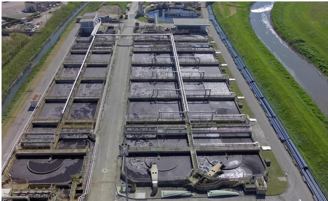
A valle della sezione di denitrificazione si realizza il 2° stadio di ossidazione biologica con vasche “a carosello”. Dosaggio di ARIA tramite tappeto di aeratori a bolle fini limitato ad alcune zone della vasca.
