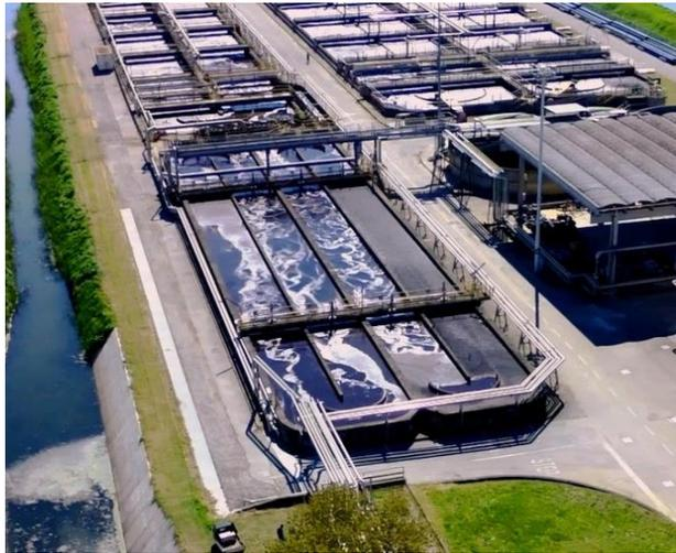
Denitrificazione. Rimozione dell' azoto nitrico formatosi dall'ossidazione dell' ammoniaca, tramite batteri eterotrofi operanti in ambiente anossico.
